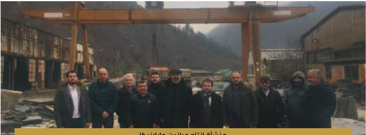
منشأة إنتاج جرانيت جابلانكا
